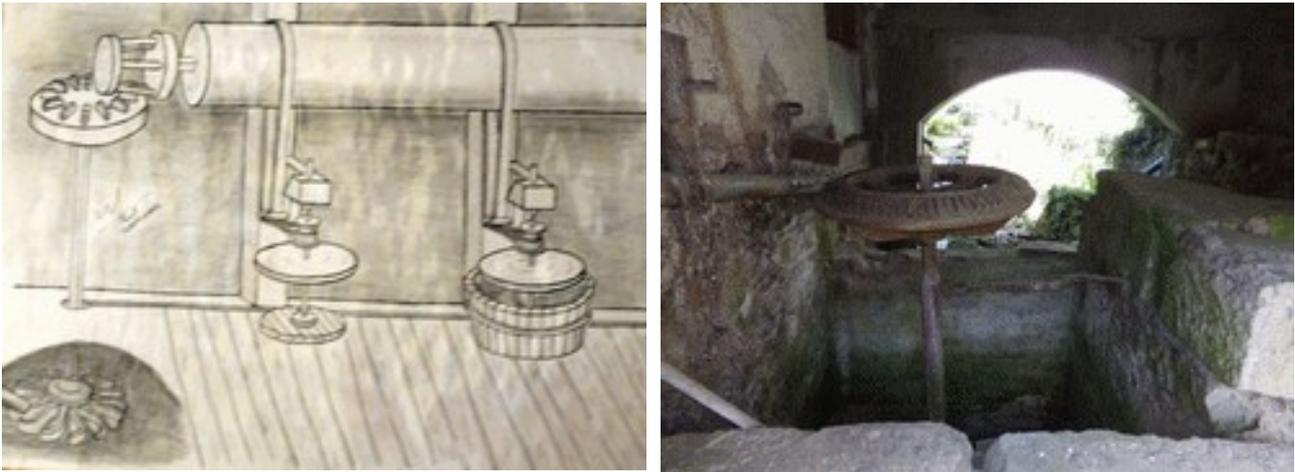
Figures 19 et 20 - Mécanisme d'un moulin à jayet. (Dessin Marc Meurisse) et Crapaudine d'un moulin à jayet.
